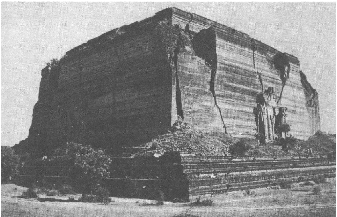
Der Sockel der unvollendet gebliebenen Pagode. Er ist massiv und 50 m hoch. 1838 wurde er durch ein Erdbeben beschädigt.
